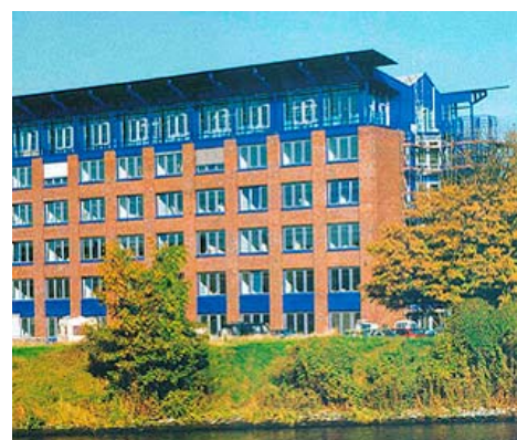
Standardkessel GmbH in Duisburg
